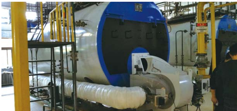
华润紫竹天然气锅炉超低氮燃烧改造
